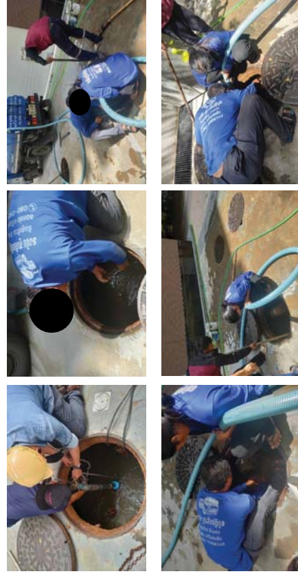
การสูบลบตะกอนจากระบบบำบัดน้ำเสีย
